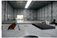
Ab. 30 Bestrijfverhardingen in beton met gerecycleerde granulaten (binnen en buiten).
