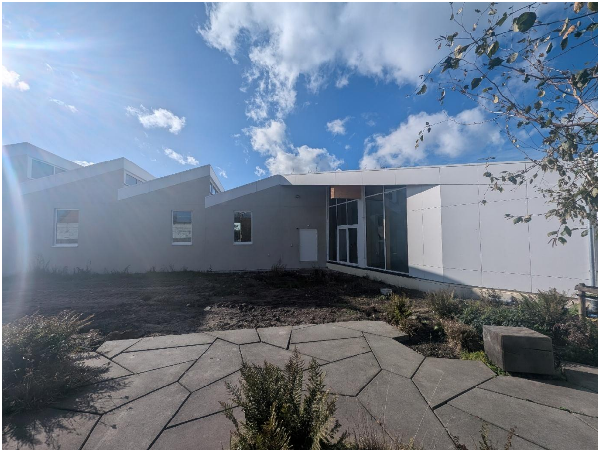
Circular Concrete Center: Pannestraat 142, 8630 Veurne, buitenzicht
