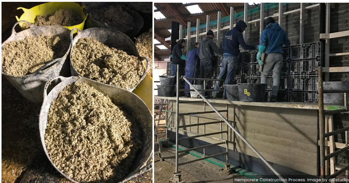
Figuur 9: Hennepbeton ter plaatse gestort door a10studio 136 . Links: emmers met verse hennepbetonspecie klaar om te storten. Rechts: een wand met hennepbeton die wordt gestort.
