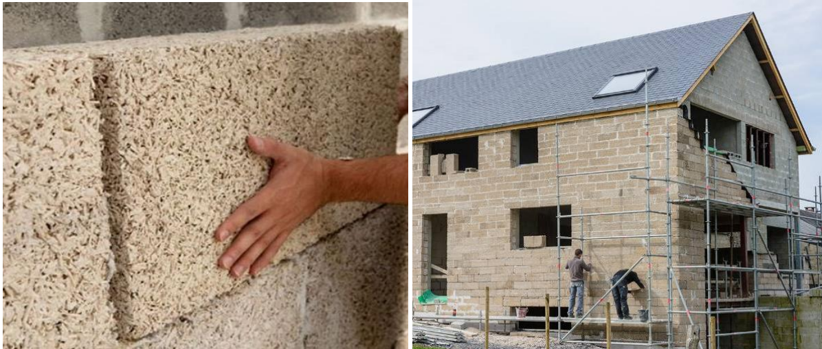
Figuur 10: prefab isohempblokken die geplaatst worden 134 .
